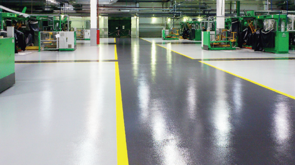
Промышленное полимерное покрытие на заводе Pirelli, г. Воронеж, 2013 г.
