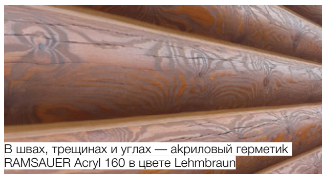
Фасад — лазурь ADLER Pullex 3in1 Lasur в цвете LW 11/5 Thuja. Три функции для защиты древесины — пропитка, грунтовка и финишное покрытие
