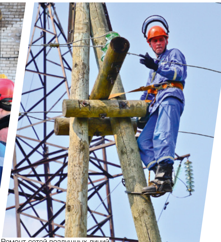
Ремонт сетей воздушных линий
